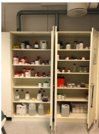
God orden på ventilerte avtrekkskap
